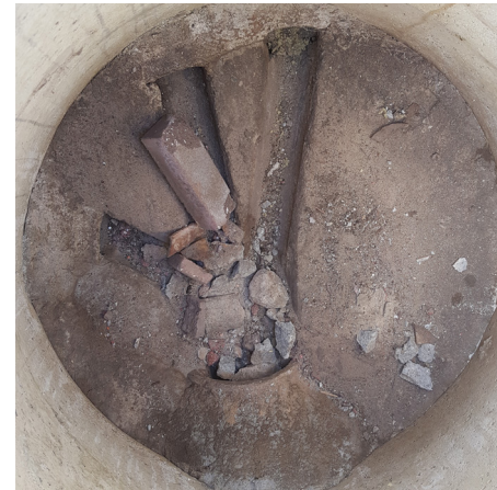
Brønd med brokker og ødelagte banketter.
