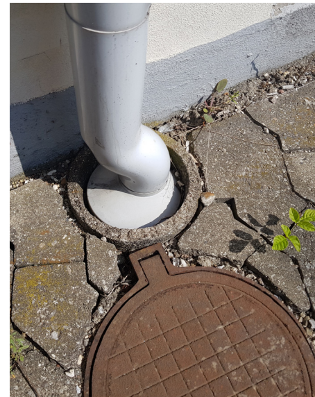
Tagnedløb, der slutter tæt til brønden.
