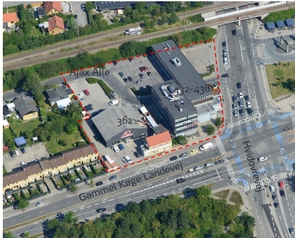
Figur 3.1: Det nye rammeområde 3C10 på hjørnet af Gl. Køge Landevej og Hvidovrevej (markeret med rød stiplede linje). Frihedens Station ses i den højre side af billede.
