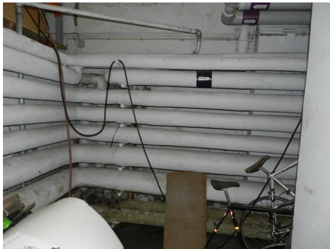
Figur 3: Nedre rør fuldstændig dækket af skimmelsvampe.
