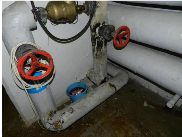
Figur 2: Omfattende vækst af skimmelsvampe på rørisolering/lærred.
