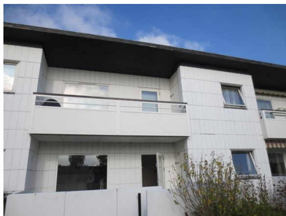
Foto viser indvendig maleristandsat samling mellem facade og etagedæk og tilsvarende udvendige detalje facade og altan
