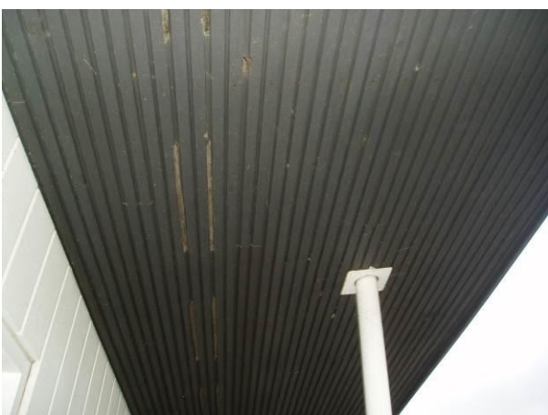
Udhængslister med insektnet på overside
