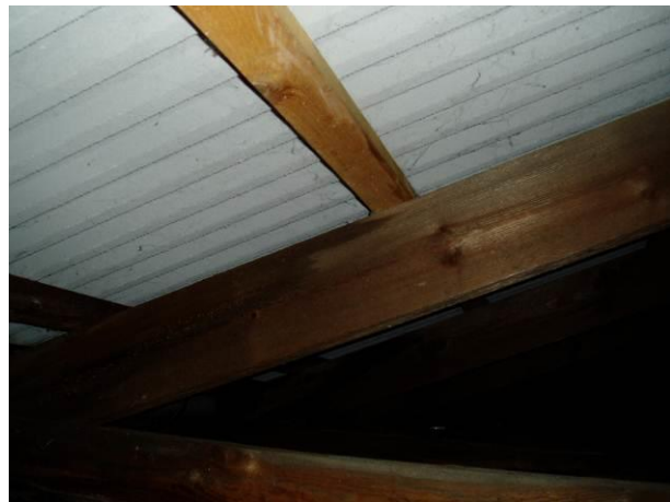
Foto visende kraftigt opfugtet tagværk i tagfod og spærkonstruktion
