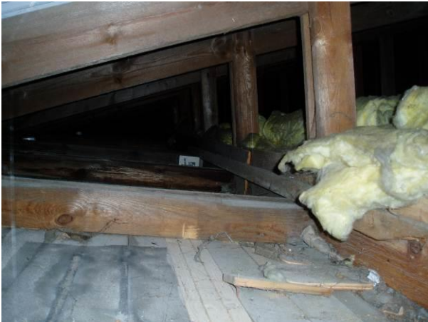
Foto visende insektnet på overside af udhængslister og opfugtet spær i tagfod.
