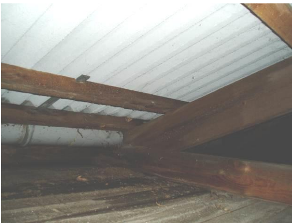
Foto visende kraftigt opfugtet tagværk i tagfod og spærkonstruktion
