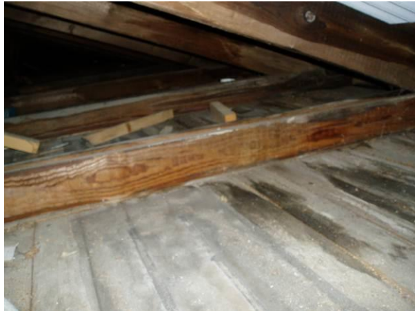
Foto visende insektnet på overside af udhængslister og opfugtet spær i tagfod.
