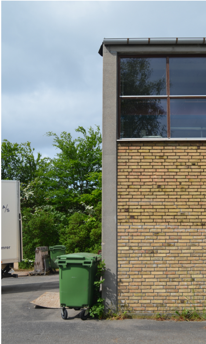
Eksisterende erhvervsbygninger ved Tårnfalkevej.
