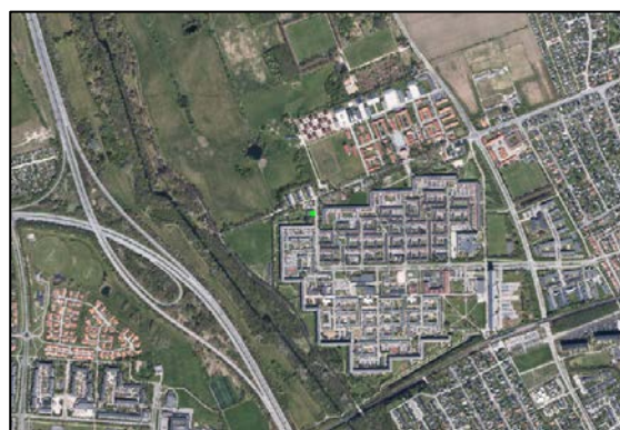
Placering af datacenter nord for Avedørelejren i eksisterende bygning hos Avedøre Fjernvarme.
