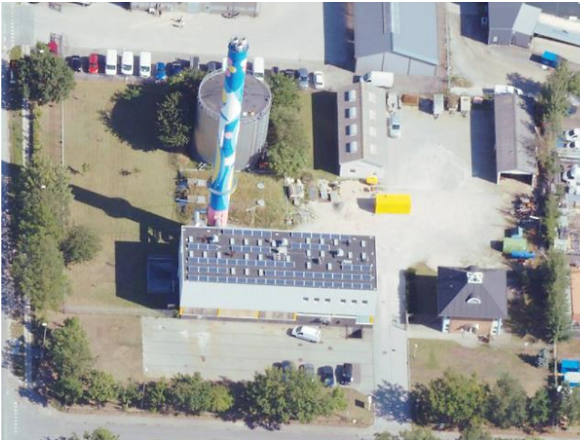
Figur 6.7 Placering af skorsten hos Fjernvarmecentralen Avedøre Holme.
