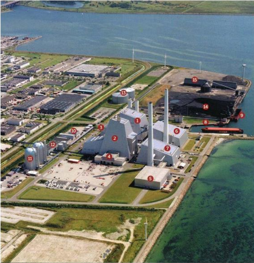
1. Kedelhus blok 1, 2. Kedelhus blok 2, 3. Administration, 4. Gasturbiner, 5. Halmlager, 6. Miljøanlæg blok 1, 7. Miljøanlæg og biomassekedel blok 2, 8. Kølevandskanal, 9. Havn, 10. Transformestationer, 11. Varmeakkumulator, 12. Fjernvarmepumpestation, 13. Olietanke, 14. Kulplads, 15. Træpillelager. Bemærk at der i område 15 i dag er etableret en stor lagersilo til træpiller som ikke fremgår af denne oversigtsplan.
