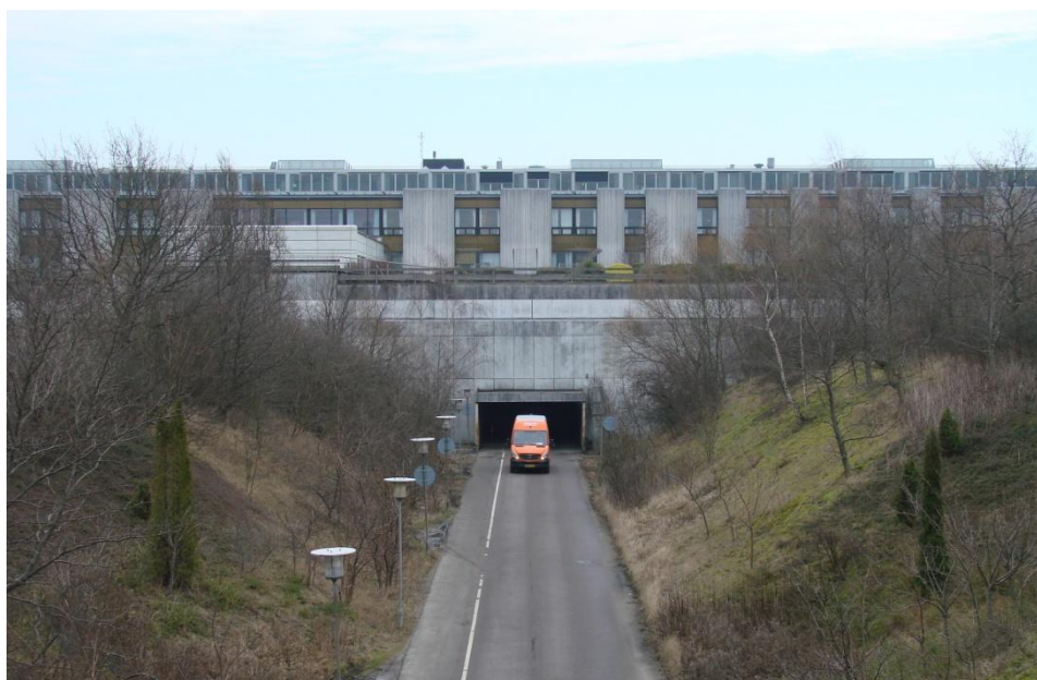
Den vestlige facade på Kettegård Allé 30.
